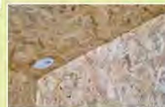
Finition intérieure avec plafond en OSB3 et grilles de ventilation
