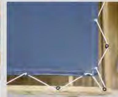
Fixation par sandow, poulies et rail arrière avec bavette d'étanchéité intégrée
