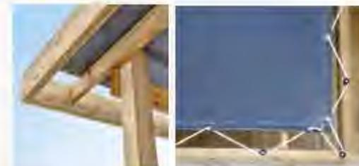
Charpente avec débord de 23 cm de chaque côté + fixation par sandow, poulies et rail arrière avec bavette d'étanchéité intégrée
